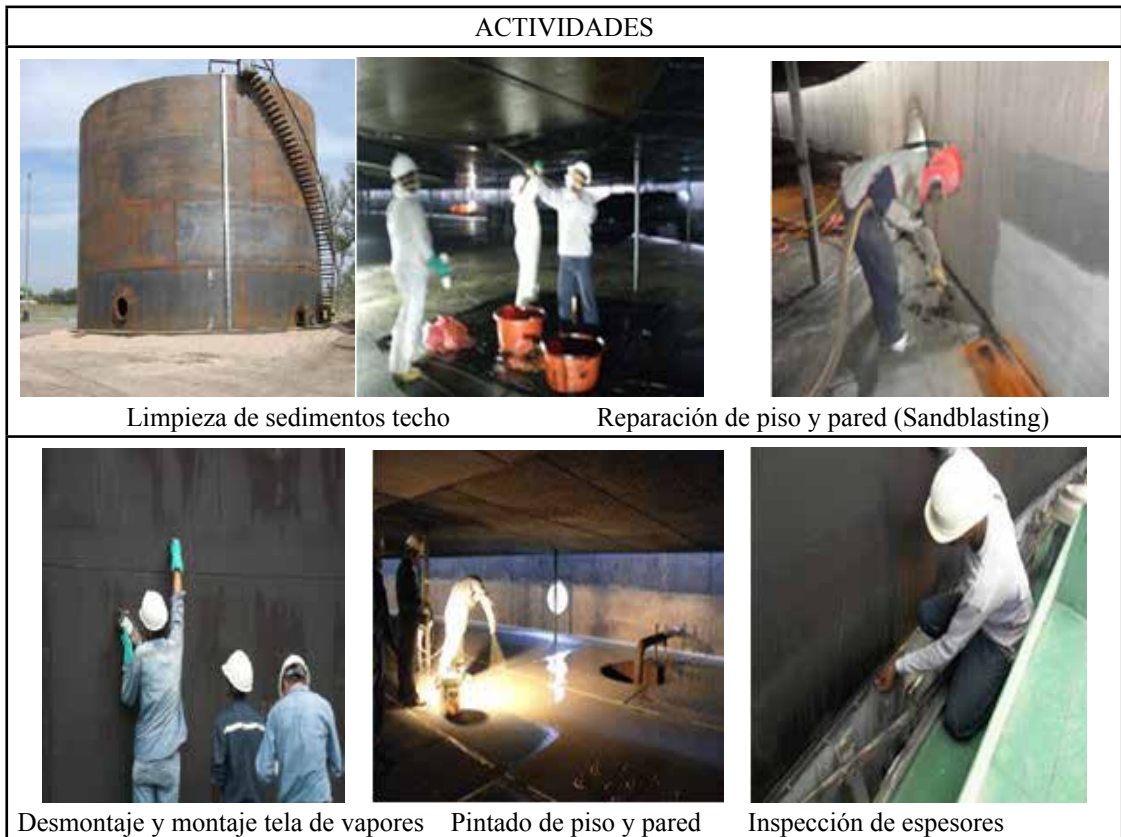
Figura N° 2. Ejemplos de actividades realizadas en el mantenimiento del tanque de almacenamiento de petróleo.
