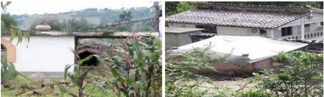
Figura 3. Proximidad de los hornos de emisión de plomo a las viviendas (dentro y fuera de las viviendas)
