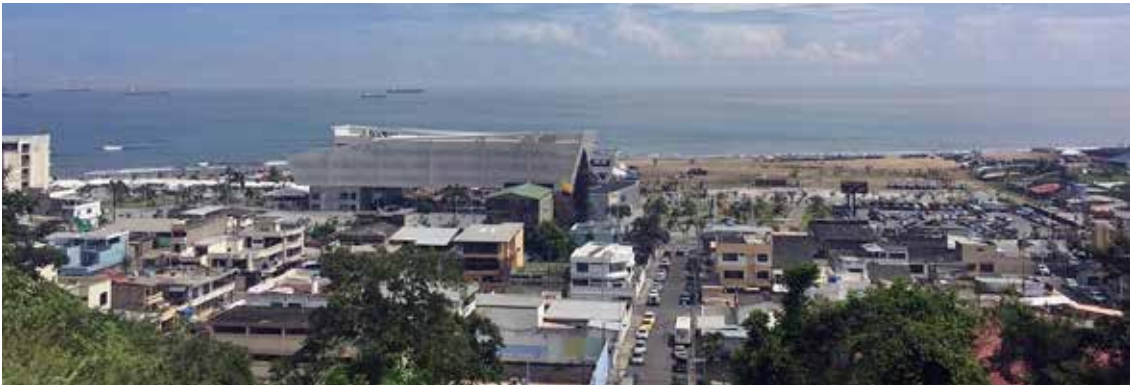
Foto 13: Nuevo edificio de oficinas de la Flota Petrolera Ecuatoriana (FLOPEC), sector Las Palmas, zona de influencia directa de tsunamis.
