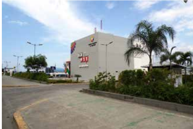
Foto 12: Instalaciones del Centro ECU 911 de Esmeraldas en zona de afectación directa por tsunami.
