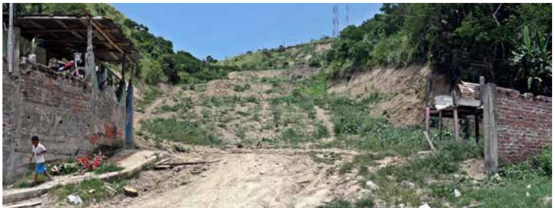
Foto 9: Deslizamiento del 25 de Enero de 2016 que afectó al Barrio 20 de Noviembre, a un año de la tragedia.
